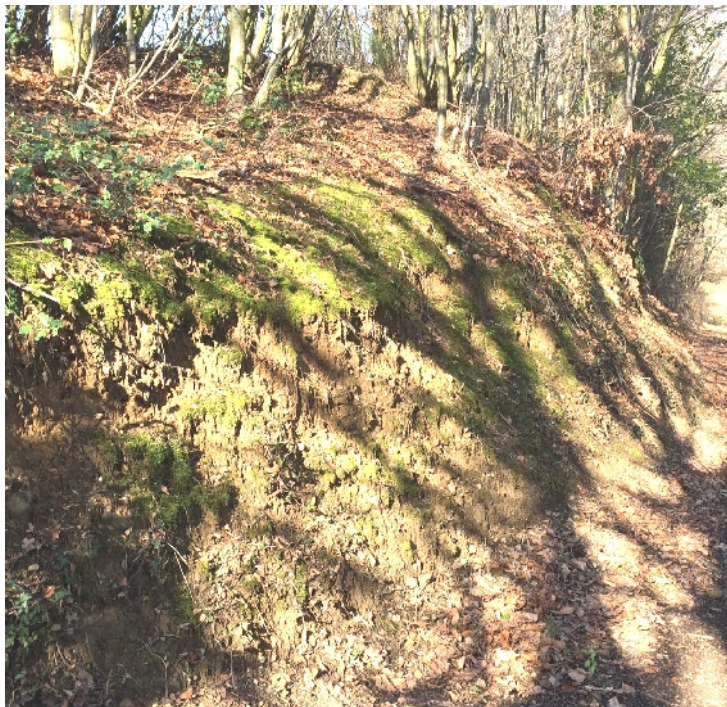
Figure n°8: Zone de glissement en rive droite du ruisseau des Rivaux
