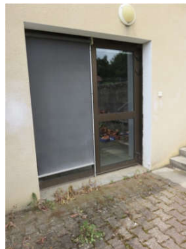
Photo MR – 21 juin 2019 - accès PMR
