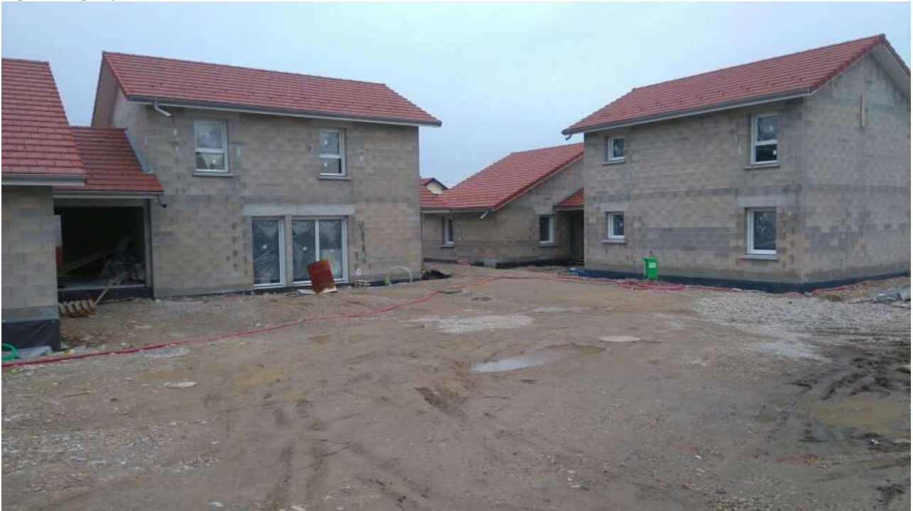
Logements groupés en cours de construction
