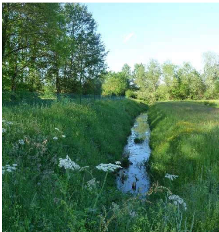
Fossé à proximité du lagunage
